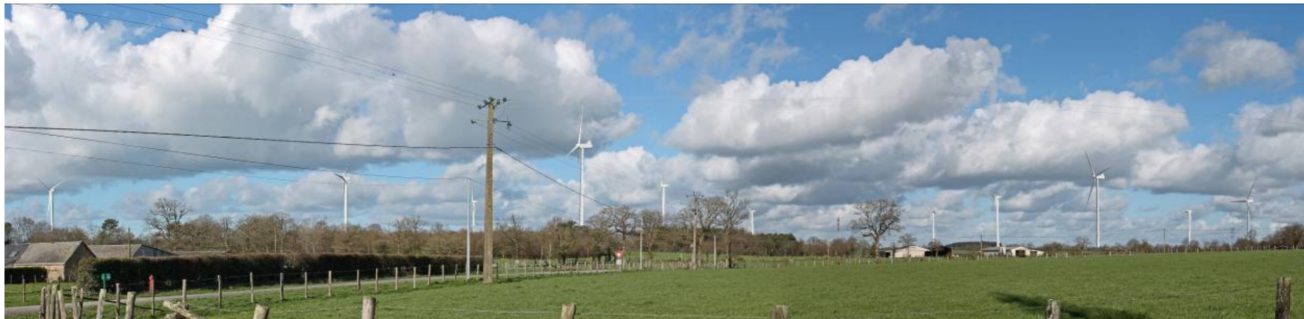
Site éolien de Derval II Loire Atlantique (44)
